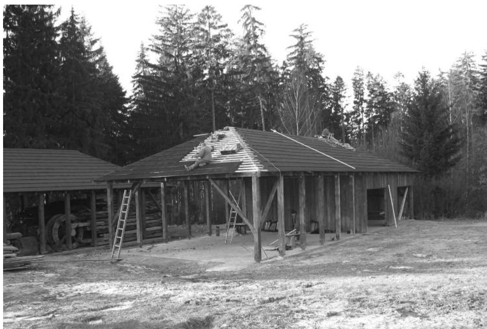
Obr. 1. Kladenie strešnej krytiny na skládku. Foto J. Neplech, 2009
