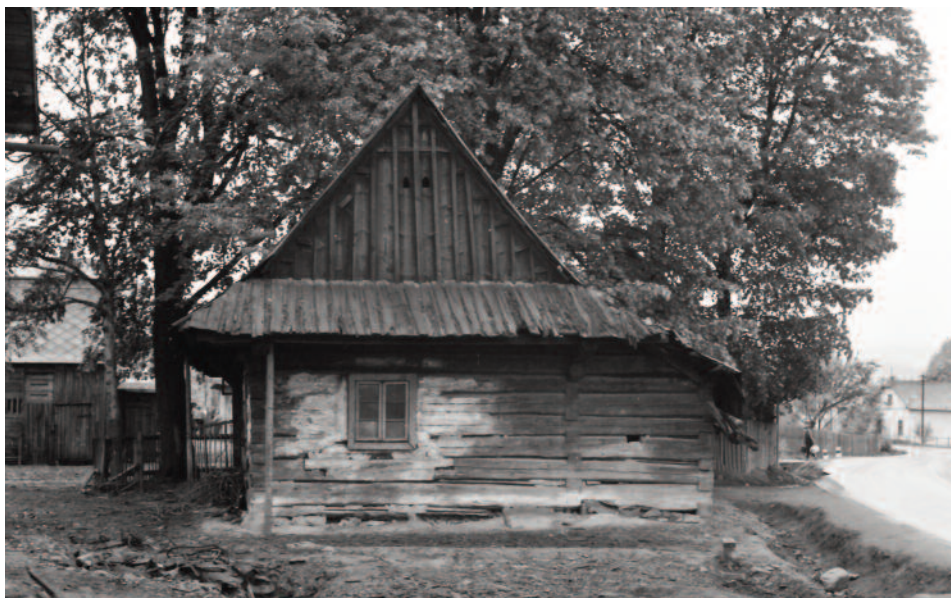
Obr. 1. Dvojdom č. 295 – 296 na pôvodnom mieste, čelný pohľad. Fotoarchív SNM v Martine, č. neg. 53 957. Foto J. Kantár, 1967
