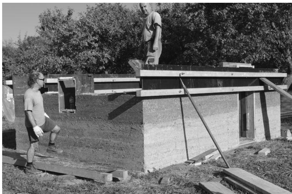
Obr. 3. Zdivo vyvedené do poloviny své výšky. Foto M. Novotný, 2011
