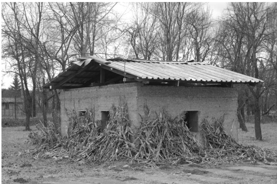
Obr. 4. Experimentální stavba je připravena k přezimování. Foto M. Novotný, 2011
