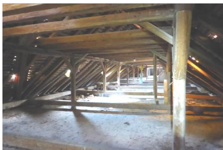
Obr. 6: Typický tvar krovu v 3.N.P.
