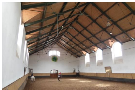
Obr. 1: Celkový pohľad na strechu jazdiarne.
