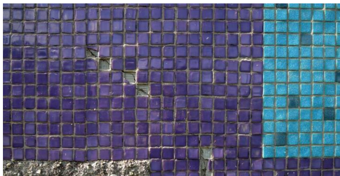
Obr. 6: Detail kombinace mozaikových kostek vyrobených technologií lití (tmavě modře) a sintrových kostek. Foto V. Říhová
