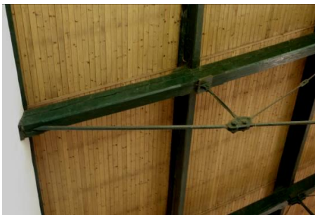
Obr. 2: Detail väzníka pri podpere.
