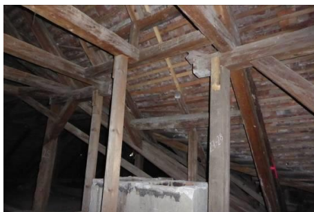
Obr. 7: Zásahy do krovu kvôli komínom.
