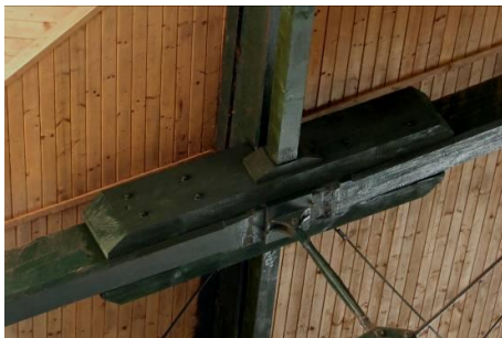
Obr. 4: Detail zosilnenia väzníka.
