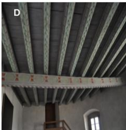
Obr. 11: Fotodokumentácia odberného miesta č.3 a č.4-stredový priečný trám tzv. „Mešternica“:
