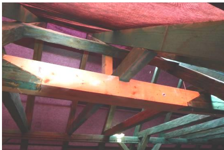
Obr.10: Doplnenie chýbajúcej väznice.
