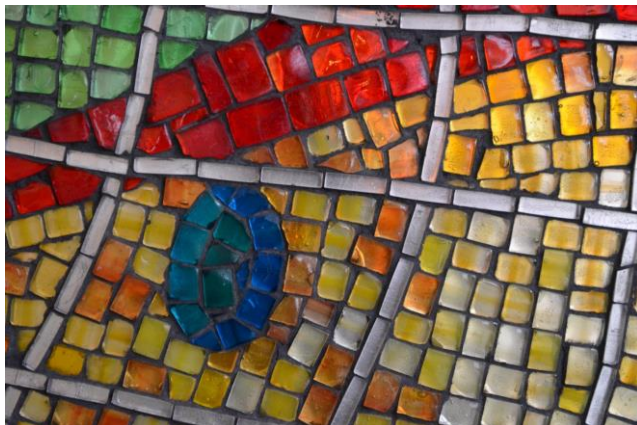
Obr. 4: Detail železnobrodské mozaiky zhotovené z prefabrikovaných vertikálně mačkaných kostek, které byly osazené na hliníkový plech přitavením pomocí polyvinylbutyralové folie. Kromě mozaikových kostek základní velikosti (12 x 16 mm) jsou na detailu zachyceny také kostky, jejich velikost byla upravena štípáním a kostky odlišných rozměrů. Foto I. Kučerová
