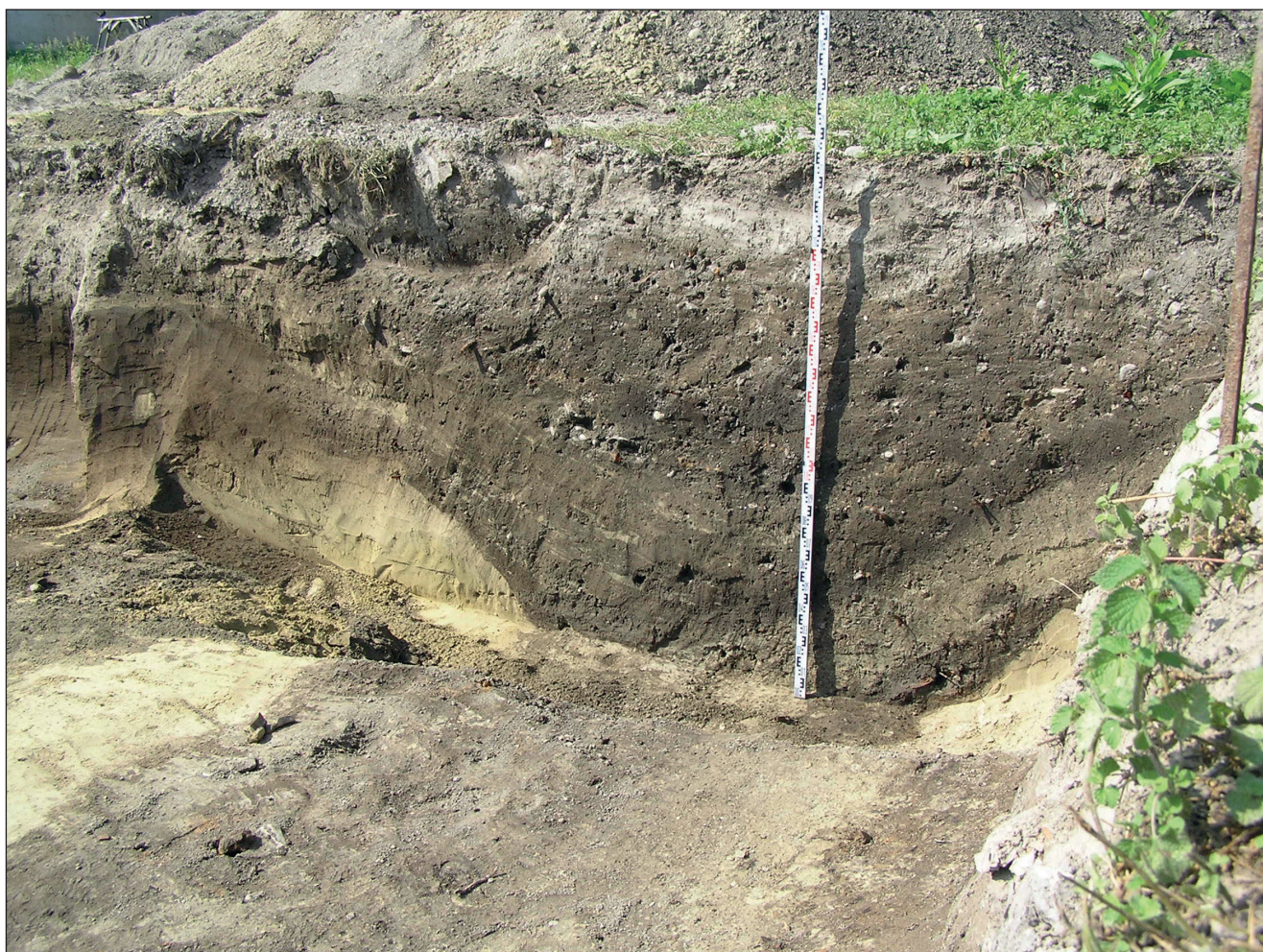
Obr. 9. Objekt 1 - západný profil. Foto: J. Schmidtová
