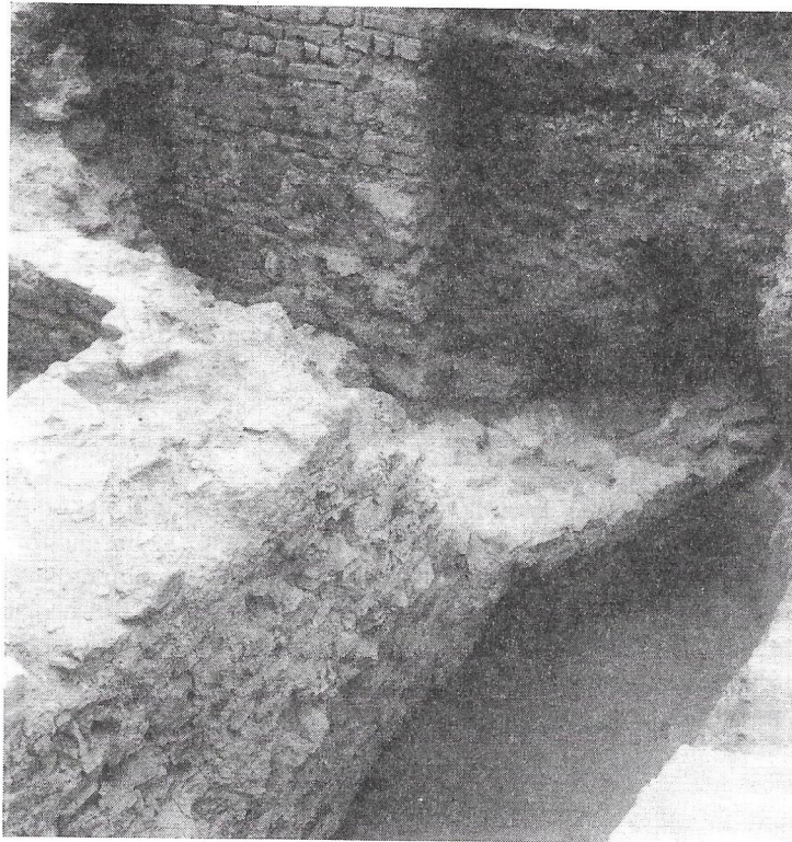
Obr. 3. Trnava, kostol sv. Michala. Pohľad na juhozápadné nárožie kamennej krypty
