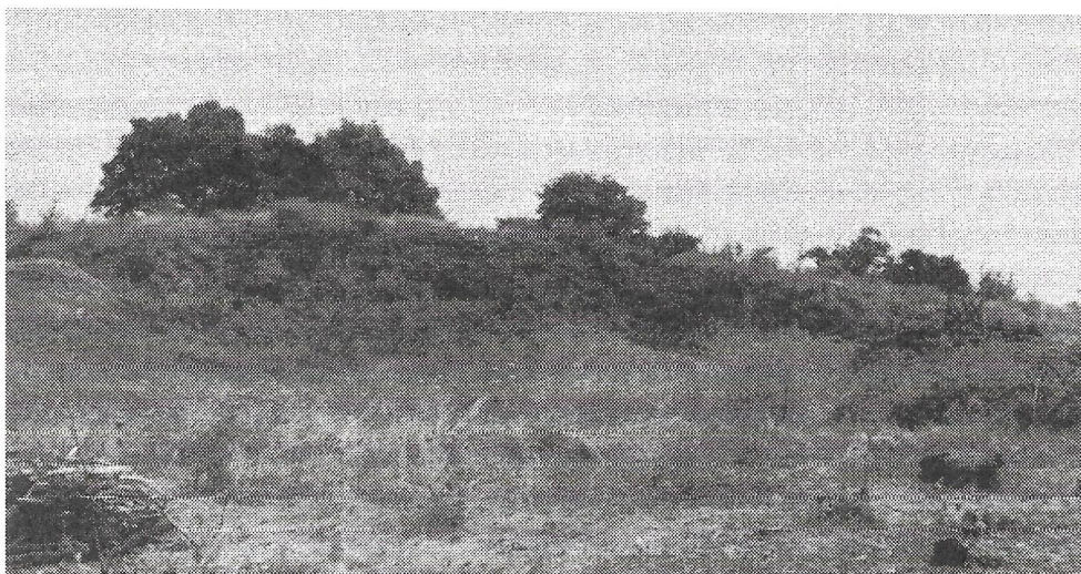
Obr. 5. Bratislava, Polianky. Severozápadná časť opevnenia po odstránení porastu
