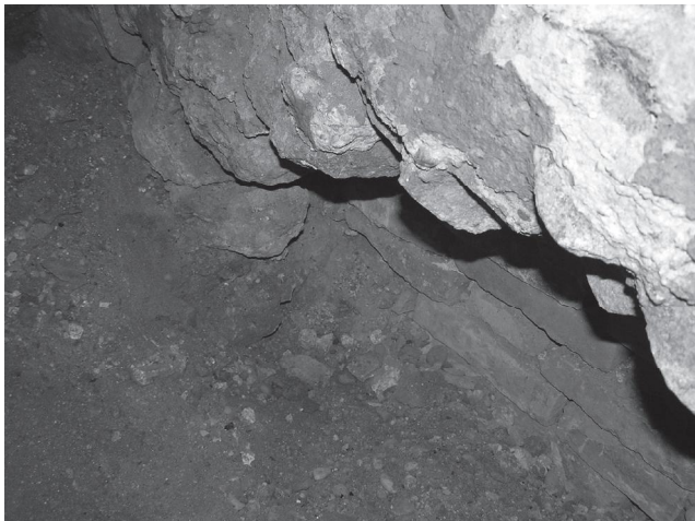
Obr. 9 Segment v základovom múre južnej steny s tehlovou zámurovkou – Rez J
