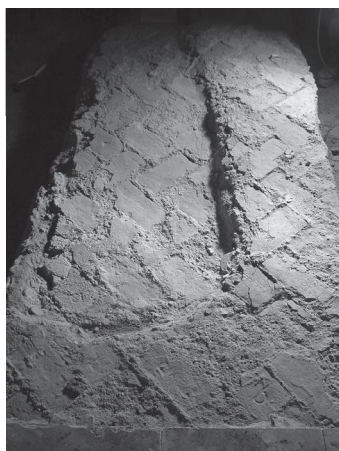
Obr. 4 Odtlačky barokovej tehlovej dlažby na stredovom kontrolnom bloku pri hlavnom vstupe s prepadom do HJ č. 4
