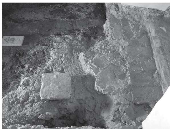
Obr. 5 Superpozícia dlažieb v južnom (bočnom) vstupe s príkladom umiestnenia kvadratickej dlaždice na tzv. renesančnej dlažke
