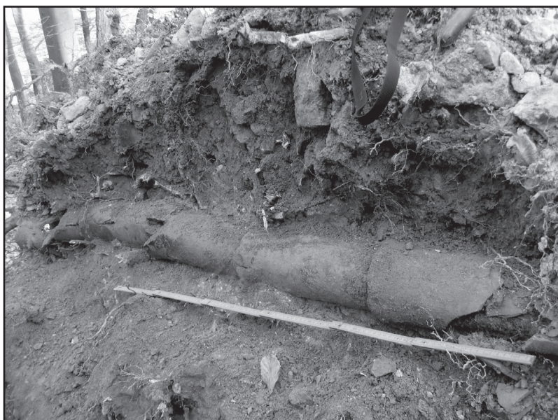
Obr. 6 Časť vodovodného potrubia odkrytého vo februári 2011 na polohe Trúby.
