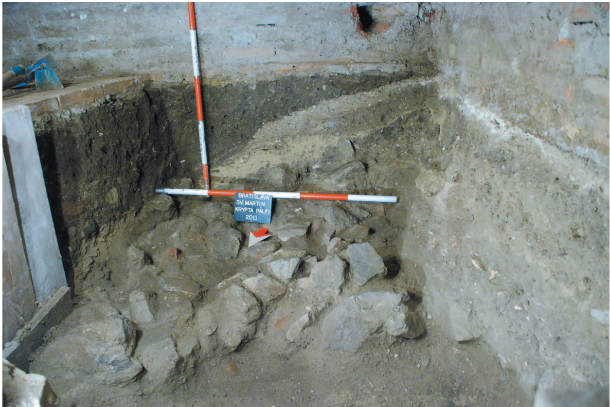
Obr. 3 Deštrukcia z lomového kamenného muriva (foto: I. Choma).
