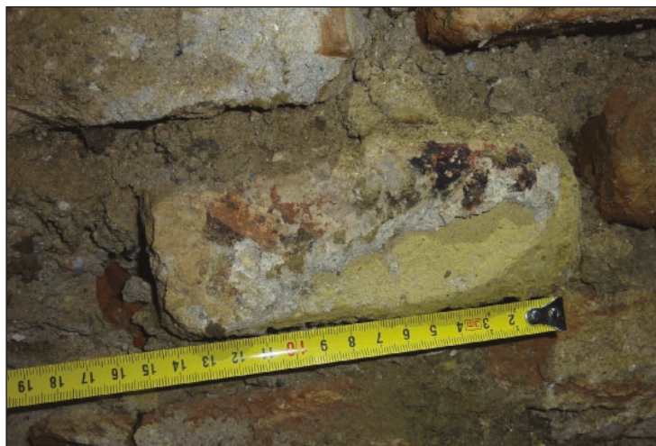
Obr. 9. Tehla primárneho kostola s fragmentmi polychromie sekundárne použitá v južnom základe presbytéria Foto R. Erdélyi.
