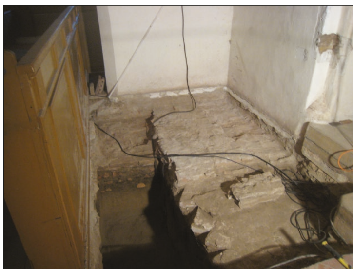
Obr. 8. Sonda S12 v SV kúte dvojlodia počas prác. Časť základu baldachýnového oltára, dole zvyšok paralelného základu z primárnej etapy Foto A. Botek.
