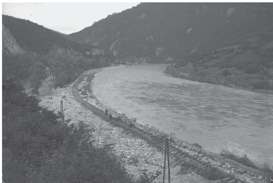
Obr. 6, 7. Poškodená povodňou a opravená železničná trať a násyp za Vrútkami v roku 1903, Domašínsky meander. Fotoarchív SNM v Martine, č. neg. NG-002215, NG-002218. Foto P. Socháň
