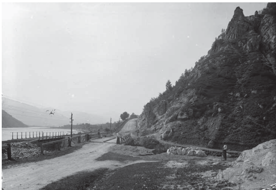
Obr. 1. Úprava brehov a násypu železničnej trate pri Ratkove, resp. vyústení Snilovského potoka do Váhu. Fotoarchív SNM v Martine, č. neg. NG 002298. Foto P. Socháň, 1893 – 1912
