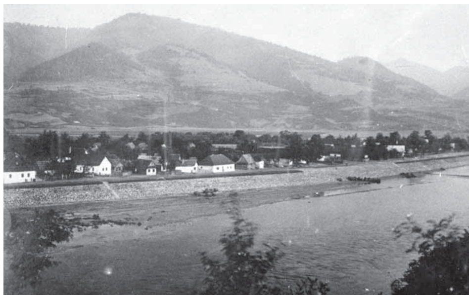
Obr. 30. Pozdĺžna regulácia brehov Váhu pri Kraľovanoch realizovaná v rokoch 1931 – 1933. Fotoarchív SNM v Martine, č. neg. NG-151981-002. Autor foto neznámy, reprodukcia M. Fabian
