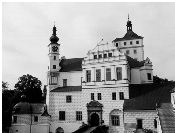
Stav hlavní budovy pardubického zámku v roce 1993 a v roce 1998
